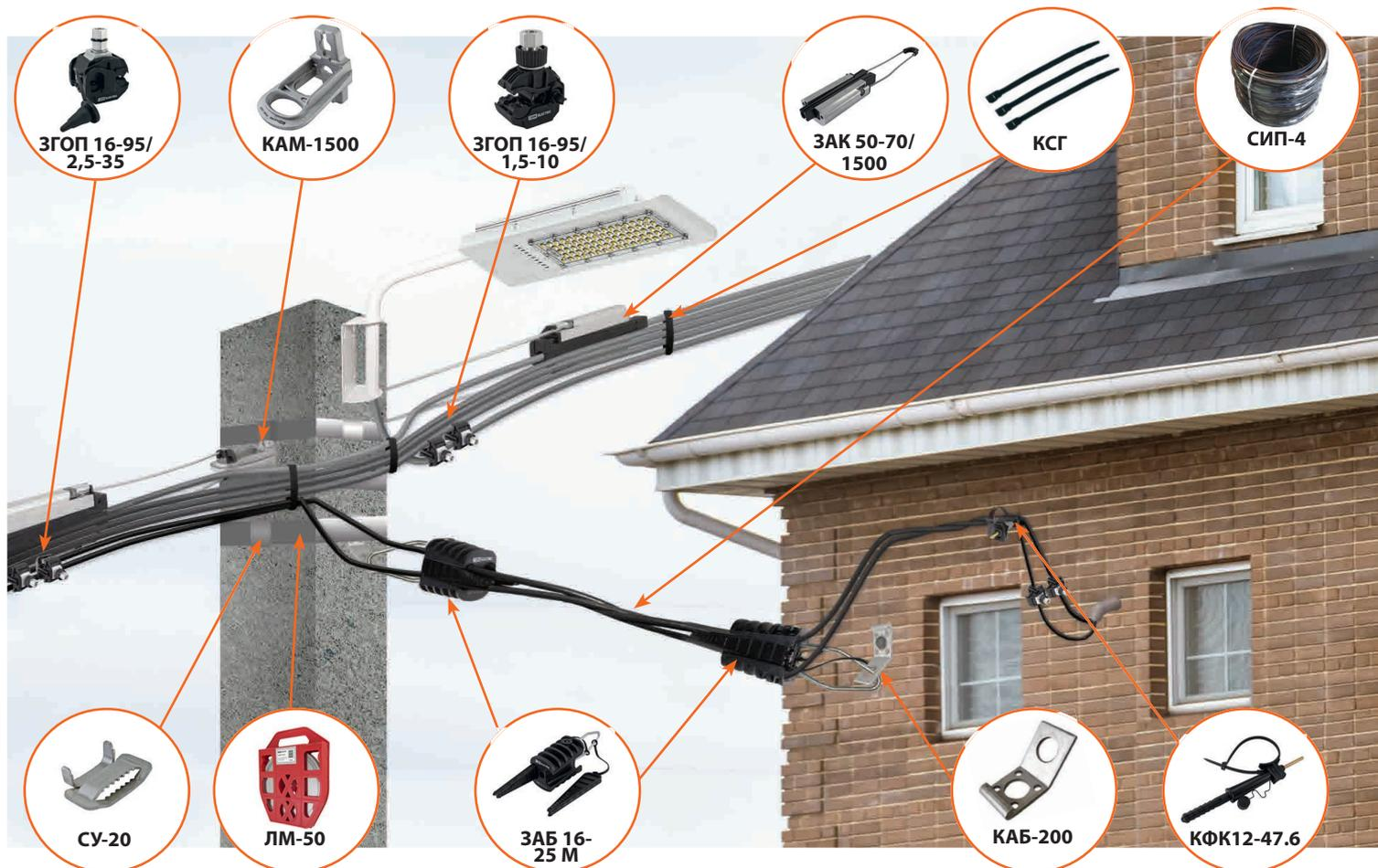
Типовая схема для подключения абонентов
